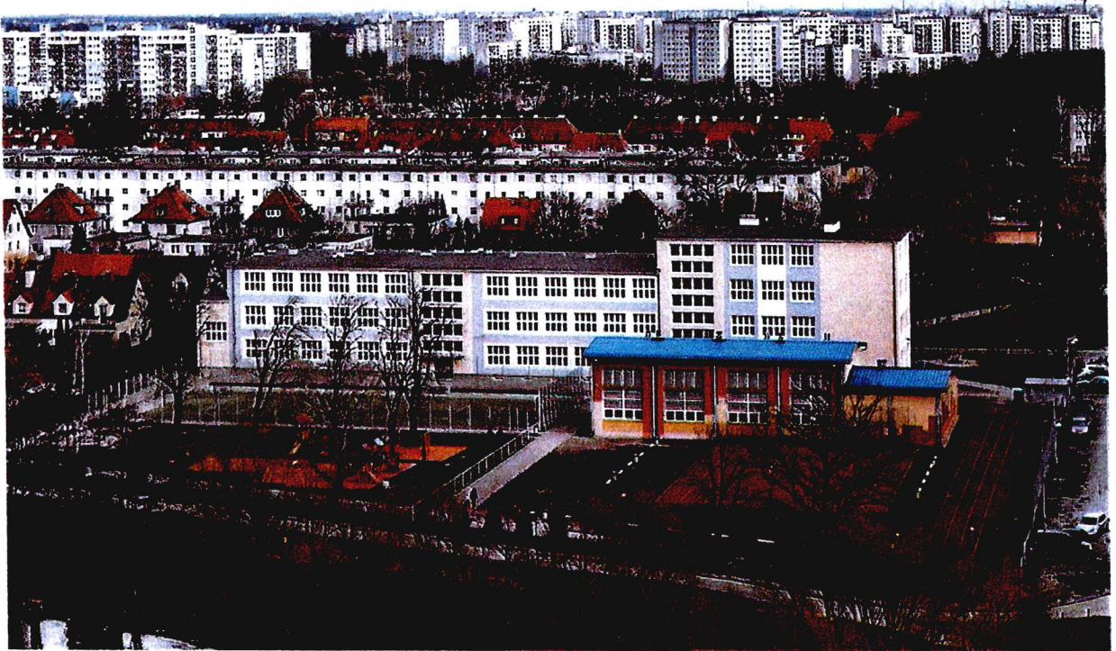
Elewacja po rozbudowie o jedną kondygnację
